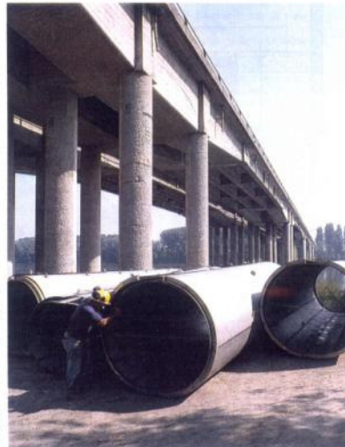
Le cornici di protezione dei pali, realizzate in acciaio inox AISI 304.
