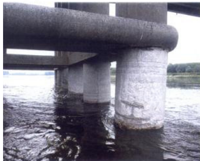
Un palo durante la fase di ripristino.
