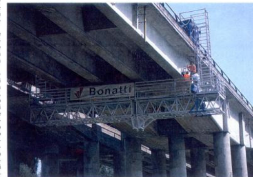
L'utilizzo di posavivoli semoventi ha consentito l'ingombro minimo della carreggiata.
